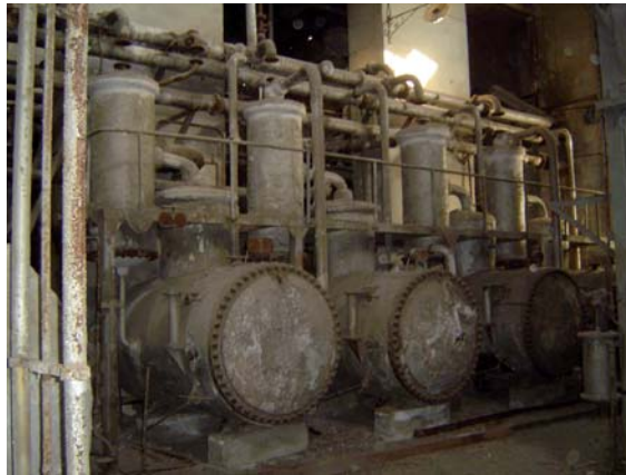
Figura A1.28 Calorifugados de diferentes tipos y composición
