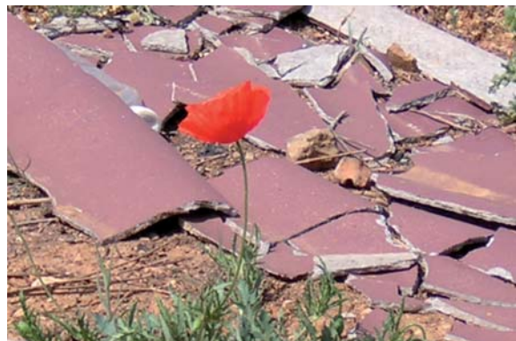
Figura A3.26b Residuos de fibrocemento (cubiertas) acondicionados para su retirada
