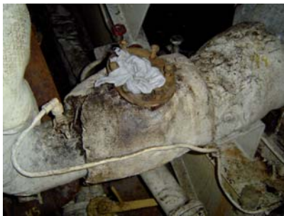
Figura A1.29 Detalle de calorifugado (textiles)
