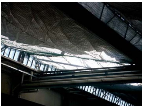
Figura A3.4 Colocación de una lámina de plástico para recoger residuos que puedan caer durante la retirada de una cubierta de fibrocemento
