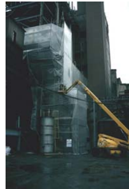
Figura A3.7b Burbuja para la retirada de calorifugados y otros MCA de una caldera en una central térmica
