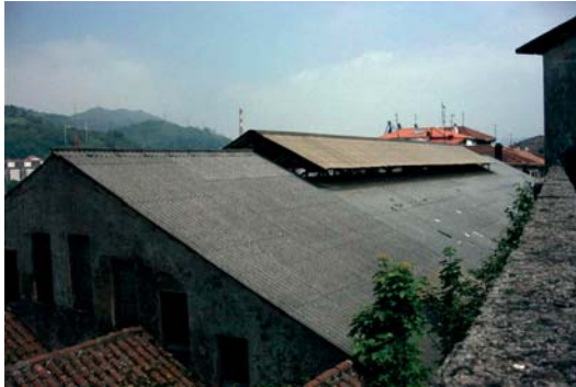
Figura A1.18 Placas onduladas y planas (cubiertas)
